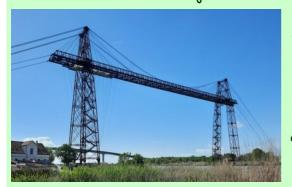
monde. Au XIXème siècle, le seul moyen de traverser la Charente entre Rochefort et Echillais est le bac. Ce système étant limité, il est envisagé de construire un pont. Le projet proposé par Ferdinand ARNODIN est retenu en 1897. L'ingénieux système se compose d'une partie fixe et d'une partie mobile à laquelle est suspendue une nacelle. Grâce à celle-ci, on peut relier les deux rives sans gêner la circulation maritime. C'est sur cette nacelle que nous montons tous pour
